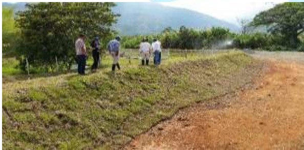
Obra de protección de la PTAP – Corregimiento El Placer – Cerrito
